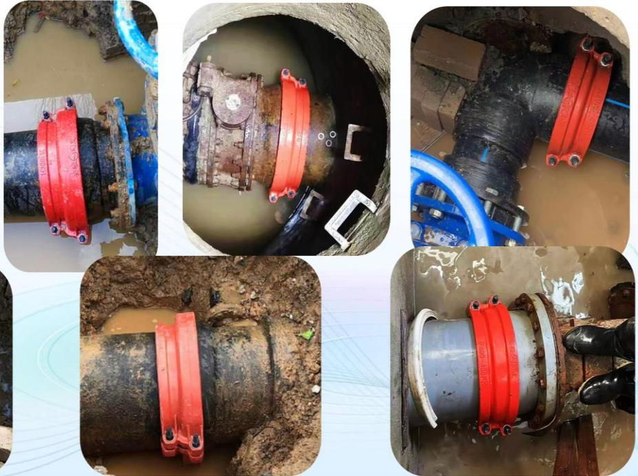
安徽合肥一小区PE管DN110弯头管件对焊位置出现破损渗漏，对焊口完全脱开，现场不具备重新热熔对接条件，为保障居民及时供水，采用P110X200防脱哈夫节，快速完成抢修。
