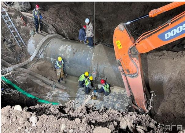
(管道开挖、清理、排查漏水点)
