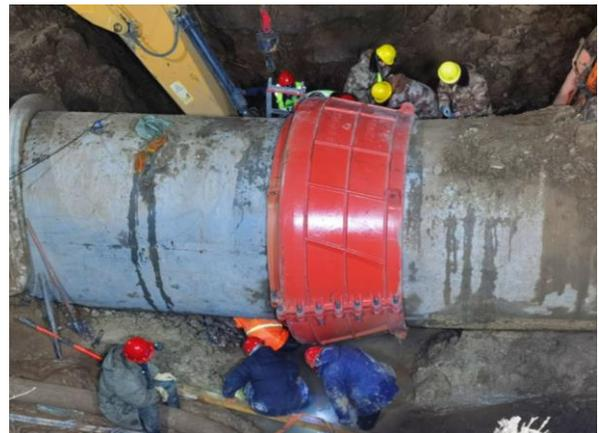
(采用 Z2000 混凝土管用球墨铸铁修补器维修)
