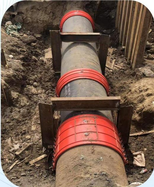
铸铁管H1400X1000直管部位和H1400承插口部位堵漏抢修
