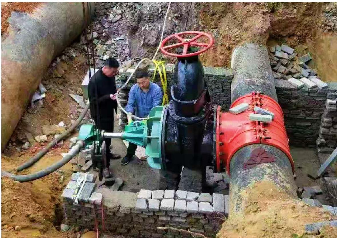
4.1.2 铸铁管 DN1400X600 马鞍式大管卡和 DK8-600 型开孔机使用现场。
