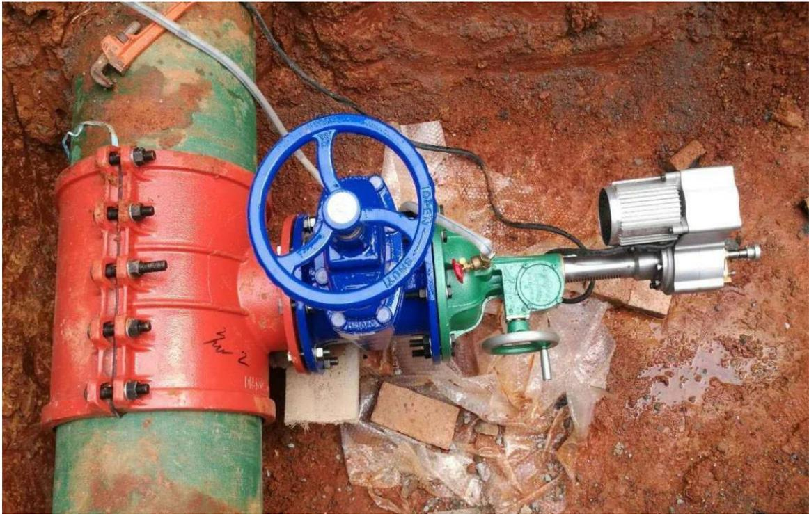
4.1.4 塑料管 P500X750-400 哈夫式管卡和 DK6-400 型开孔机使用现场
