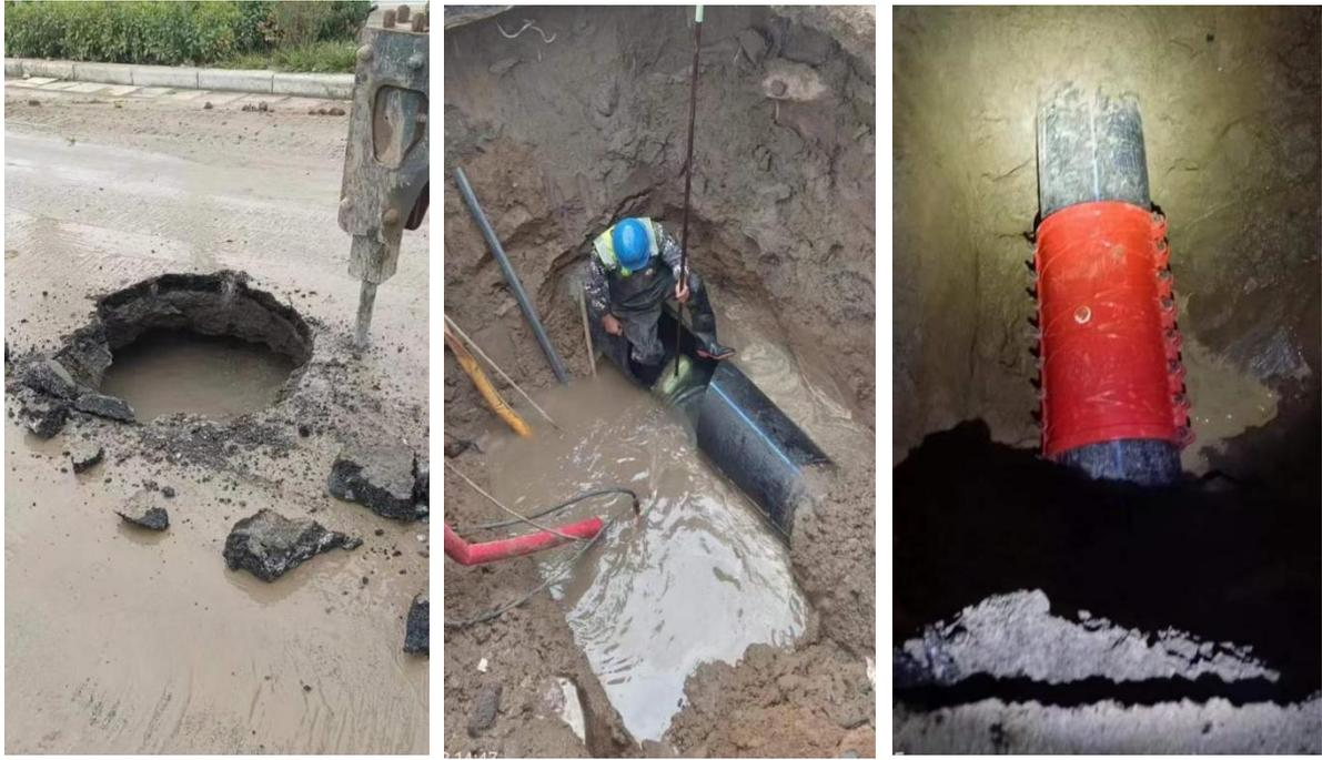
4.2.2 PE管DN315三通部位出现破损渗漏，使用P315S三通哈夫节，快速完成抢修。
