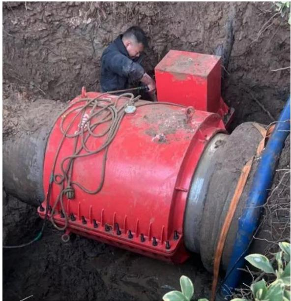
4.4.2 2025.01月浙江湖州 DN900PE 管弯头热熔口处破裂漏水，定制双 45° 弯头哈夫节完成施工。
