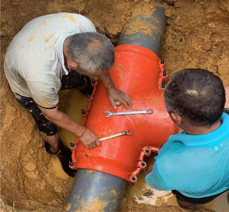
4.2.3 球墨管、塑料管（PE、PVC、PPR 等）三通、弯头承插口部位，或其它承插口因空间位置受限，使用反扣系列产品，单独对承插口部位进行快速抢修堵漏。
