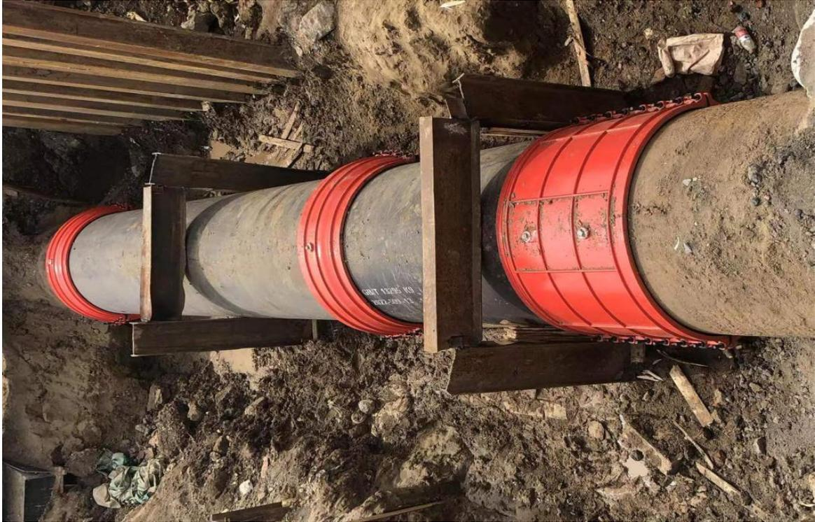
4.1.2 DN1600 球墨铸铁管道承插口部位因橡胶圈老化，密封失效导致出现渗漏，采用 H1600 承插哈夫节进行施工作业。
